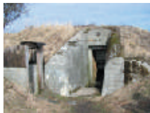
Regelbau 635, med karakteristisk tilbygning som antyder at der har været en udtalt mangel ved den oprindelige konstruktion
