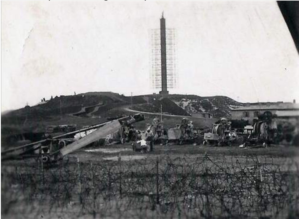
Den 60 meter høje Wassermann-radar i Sønder Vorupør.
