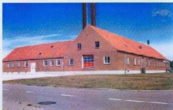
Kostforplejningen og køkkenet. Kostforplejningen er i dag Hanstholm Varmeværk. Mens køkkenbygningen anvendes som selskabs- og fritidslokaler. (foto JL 1999)
