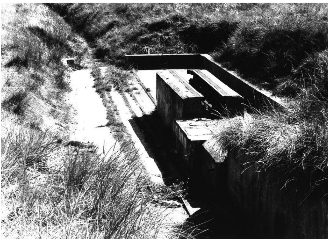
Ladeøvelsesapparatets betondele fotograferet fra nord, ca. 1975. (Per Vesterager)
