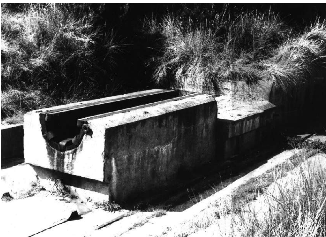
Ladeøvelsesapparatets betondele fotograferet fra sydøst, ca. 1975. (Per Vesterager)
